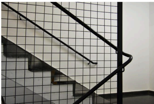
Fig.12. Detalle escaleras. Unité d'habitation de Le Corbusier en Berín, Alemania. Fotografía de Branly Pérez publicada en Metalocus
