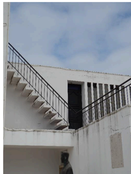
Fig.15. Detalle escalera exterior. Iglesia de Santa Luzia
