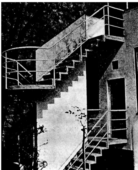
Fig.14. Detalle escaleras. Maison Antonin Planeix 10
