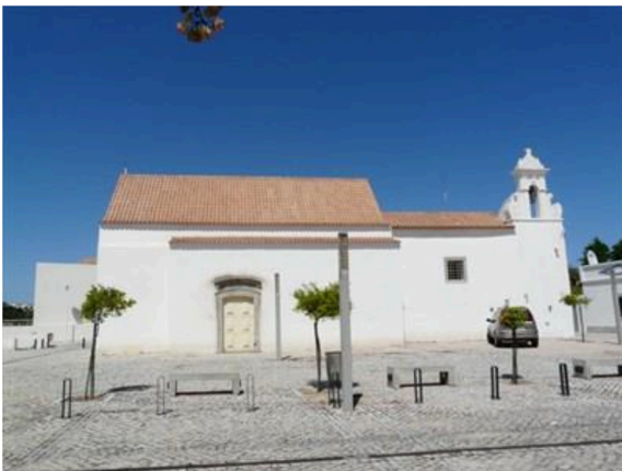
Fig.23. Fachada lateral de la capilla de Santa Ana, Tavira.
