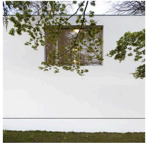
Fig.18. Fotografia de Nelson Garrido, Detalle de fachada
