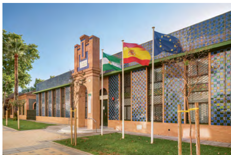
Antiguas dependencias rehabilitadas de la estación de ferrocarril de Zafra.
