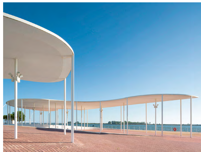
Vista del Paseo de la Ría hacia el cauce del Odiel.
