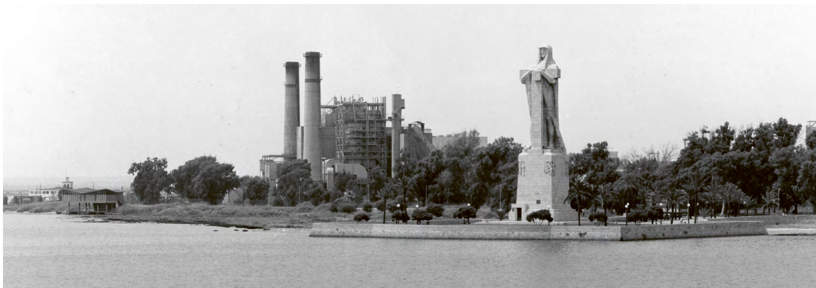
Vista de la Punta del Sebo, con el monumento a Colón e instalaciones industriales, de la central térmica.
