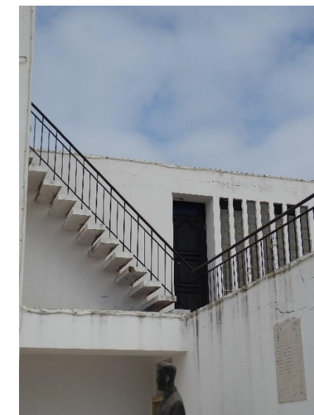
Fig.15. Detalle escalera exterior. Iglesia de Santa Luzia
