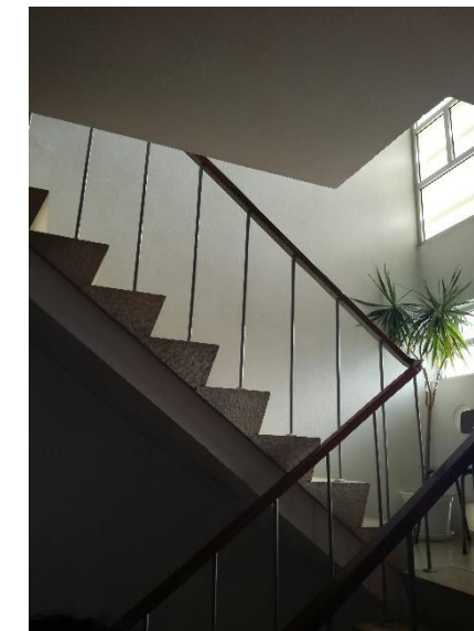
Fig.13. Detalle escaleras. Iglesia de Santa Luzia en Santa Luzia, Tavira. Fotografía A.J. Palomino
