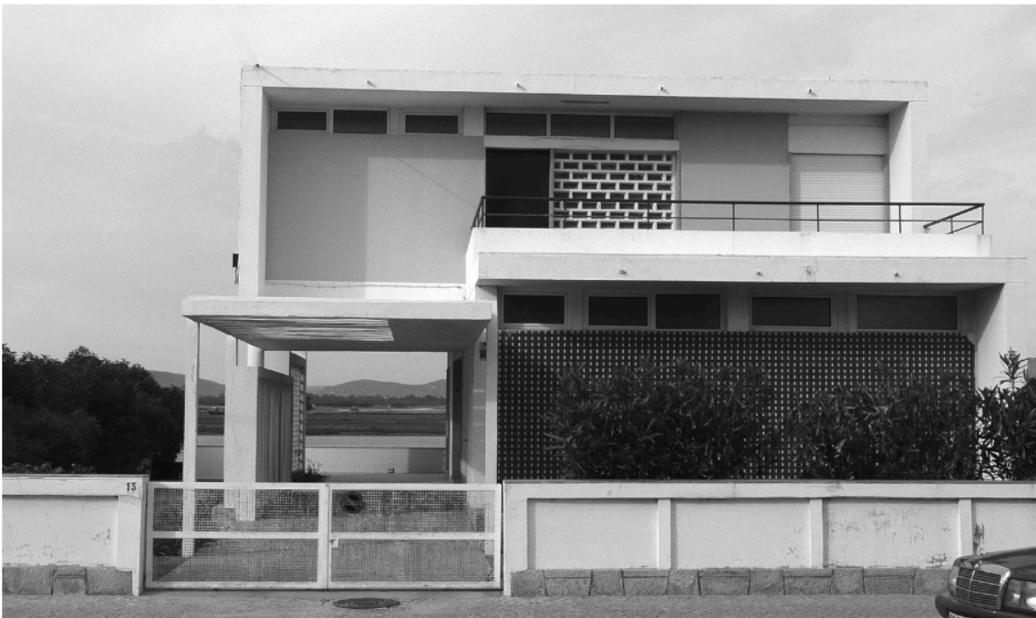
[7] MGdC, Casa de vacaciones, Avd Nascente 4, Isla de Faro, 1953 Foto JJ Parra, 2011
