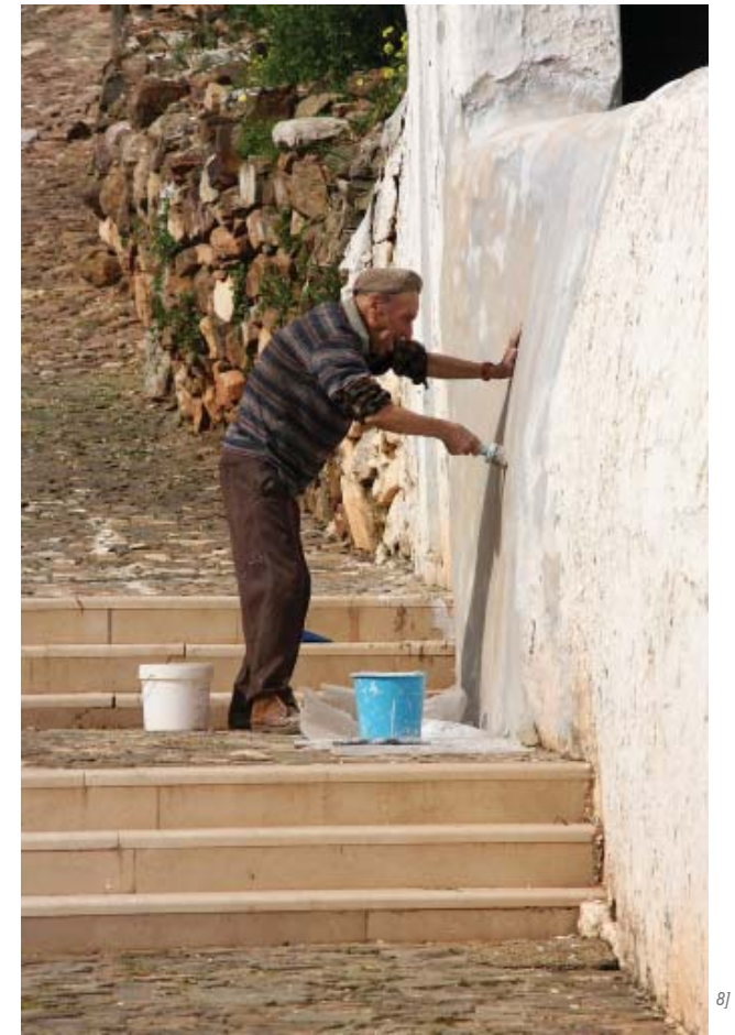
8] Reapplying the lime whitewash (caiação de cal)
