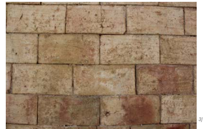
3] Terracotta clay tile flooring (tijoleira de barro / ladrilhas)
