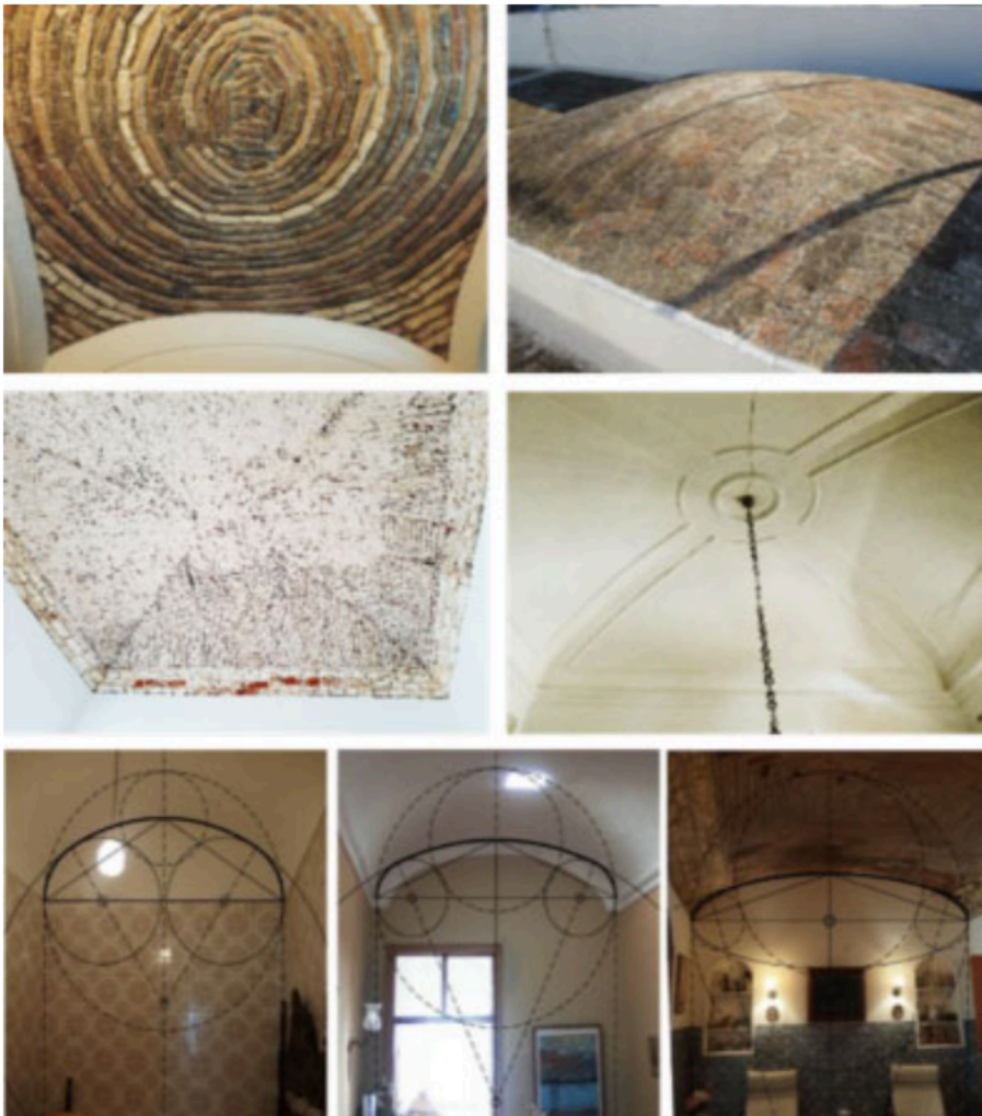
Figuur 6. (boven) Intrados en extrados van de zeilgewelven in de hoofdkamer casa de fora; (midden) Intrados van kloostergewelven in de hoofdkamer casa de fora; (onder) Geometrische constructie van boogprofielen van verlaagde tongewelven met boog met drie centra, gebaseerd op in loco-metingen (foto's van de auteur).
