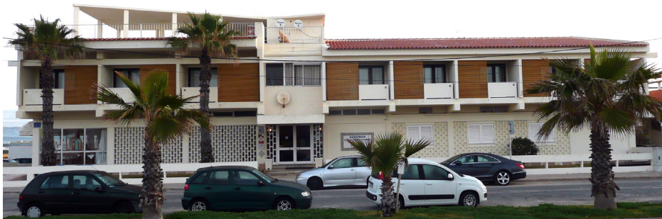
Fig. 38 y 39. MGdC. Hotel en avd. Nascente, Isla de Faro.
