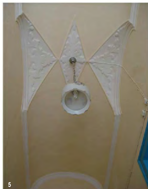
1.Fachada principal 2. Vista da açoteia na zona das abóbadas de berço abatido e da abóbada de vela 3.Pormenor da abóbada de vela da divisão principal 4.Abóbada de berço abatido da cozinha 5.Abóbada de berço abatido do corredor. (fotografias do autor entre Maio e Agosto 2009)
