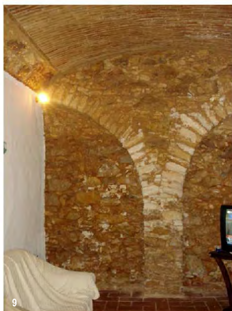
6.Pormenor do pavimento 7.Abóbada de berço abatido existente na cozinha 8.Abóbada de berço no vestíbulo 9.e 10.Arcos estruturais embutidos na parede da sala. (fotografias do autor entre Maio e Agosto 2009)
