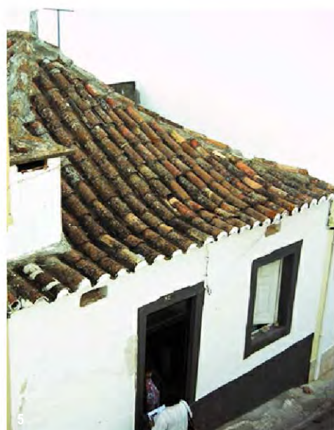
1.Pormenor do beirado do telhado de tesouro 2.Tecto de madeira da cozinha 3.Fachada principal 4.Vista da sala com tecto de madeira 5.Vista aérea do telhado de tesouro. (fotografias do autor entre Maio e Agosto 2009)
