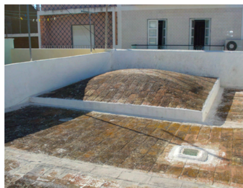
Fig.III.47 – Pormenor da açoteia sobre abóbada de vela existente no compartimento da fachada.
