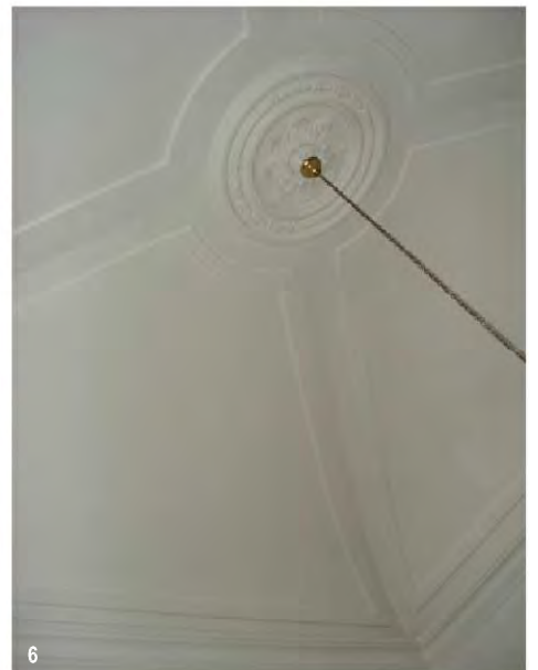
1.Fachada principal 2.Abóbada de berço abatido em compartimento interior (alcova) 3.Laje de betão armado que substituiu uma abóbada em barrete de clérigo 4.Fachada posterior com ampliações no quintal e primeiro piso 5.Pormenor da abóbada de berço abatido do corredor 6.Abóbada em barrete de clérigo da divisão principal (sala), (fotografias do autor entre Maio e Agosto 2009)
