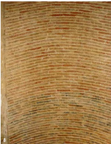
6.Pormenor do pavimento 7.Abóbada de berço abatido existente na cozinha 8.Abóbada de berço no vestíbulo 9.e 10.Arcos estruturais embutidos na parede da sala. (fotografias do autor entre Maio e Agosto 2009)
