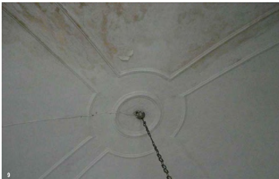
6.Abóbada de berço abatido do corredor 7.Abóbada de berço abatido da cozinha 8.e 9.Pormenor central da abóbada em barrete de clérigo da divisão principal. (fotografias do autor entre Maio e Agosto 2009)
