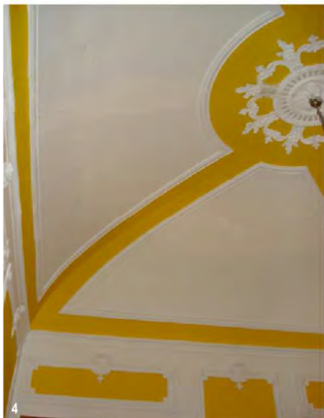
1.Fachada principal 2.Abóbada de berço abatido em compartimento interior (alcova) 3.Abóbada de berço abatido na sala 4.e 5.Abóbadas em barrete de clérigo dos quartos 6.Corredor com abóbada de berço abatido,(fotografias do autor entre Maio e Agosto 2009)
