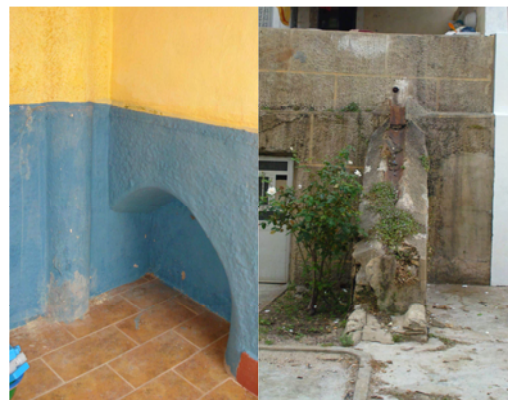
Fig.III.54 A,B - Canalização das águas da açoteia e poço adjacente localizado no terraço; contraforte com escoamento de águas do mesmo terraço, em tipologia unilateral com cobertura em açoteia na Rua Dr. Manuel Silva Ramos.
