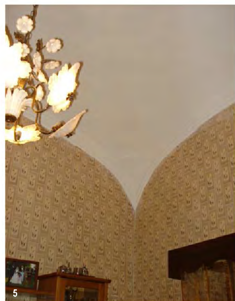
1.Pormenor das abóbadas de berço abatido de dois compartimentos interiores (alcovas) 2. Abóbada de vela do compartimento principal 3.Fachada principal 4. Compartimento interior com abóbada de berço abatido 5.Pormenor lateral da abóbada de vela do compartimento principal (sala). (fotografias do autor entre Maio e Agosto 2009)
