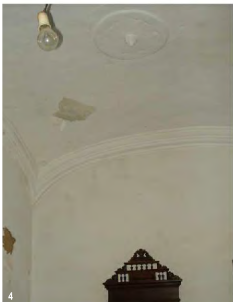
1.Fachada principal 2.Pormenor da abóbada de berço abatido no compartimento da instalação sanitária 3.Pormenor da estrutura de abóbadas e arcos 4.Abóbada de vela em compartimento interior 5.Pormenor de abóbada de berço abatido em compartimento interior 6.Vista do compartimento posterior.(fotografias do autor entre Maio e Agosto 2009)
