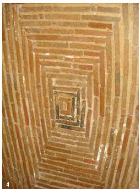
1.Pormenor lateral da abóbada de berço abatido do vestíbulo 2.Pormenor do vão da janela da divisão principal (sala) 3.Antecâmara de entrada 4.Pormenor da abóbada de berço abatido da sala 5.Vão existente no vestíbulo. (fotografias do autor entre Maio e Agosto 2009)
