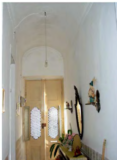
1.Abóbada em barrete de clérigo do compartimento principal (sala) 2.Pormenor central da abóbada em barrete de clérigo 3.Pormenor lateral da abóbada em barrete de clérigo 4,Fachada principal 5.Abóbada de berço abatido do corredor 6.Compartimento principal com abóbada em barrete de clérigo. (fotografias do autor entre Maio e Agosto 2009 )
