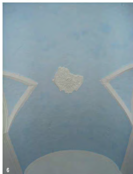
1.Fachada principal 2.Pormenor da porta principal de acesso 3.Pormenor da janela 4.Abóbada de vela do compartimento principal (sala) 5.Abóbada de vela da antecâmara 6.Abóbada de berço abatido do corredor (fotografias do autor entre Maio e Agosto 2009)
