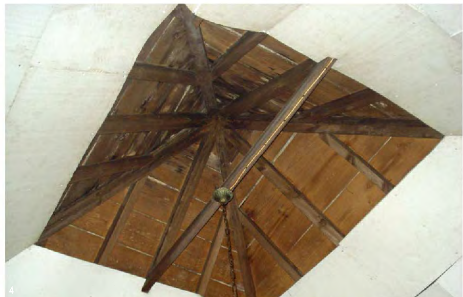
1.Pormenor do telhado de tesouro e beirado 2.Pormenor da abóbada de berço abatido do corredor 3.Fachada principal 4.Pormenor central do telhado de tesouro existente na divisão principal (sala). (fotografias do autor entre Maio e Agosto 2009)
