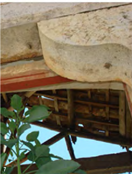
5.Vista geral do conjunto 6.Pormenor do arranque da abóbada de berço abatido 7.Pormenor da cantaria e estrutura interna do telhado de três águas 8.Abóbada de berço abatido de uma das naves. (fotografias do autor entre Maio e Agosto 2009)
