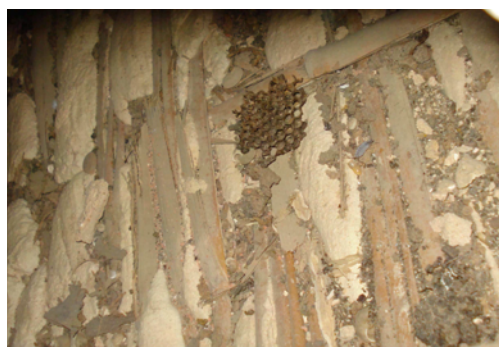
Fig.III.42 – Pormenor do forro.
