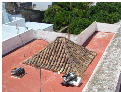
Fig.III.40 – Telhado de Tesouro na Rua da Liberdade nº45.
