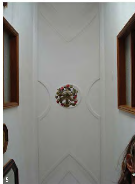
1.Fachada principal 2.Abóbada de berço abatido em compartimento interior (alcova) 3.Laje de betão armado que substituiu uma abóbada em barrete de clérigo 4.Fachada posterior com ampliações no quintal e primeiro piso 5.Pormenor da abóbada de berço abatido do corredor 6.Abóbada em barrete de clérigo da divisão principal (sala), (fotografias do autor entre Maio e Agosto 2009)
