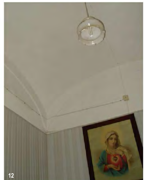
;7. Pormenor da platibanda da açoteia 8.Abóbada de vela numa das divisões interiores (alcova) 9.Pormenor lateral da abóbada de vela e passagem para a divisão principal 10.Vista da açoteia 11.Escada exterior de acesso à açoteia 12.Abóbada de vela numa das divisões interiores (alcova), (fotografias do autor entre Maio e Agosto 2009)
