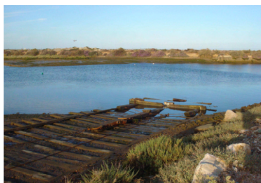
Fig.1.7 – Ribeira do Tronco e início do canal.
