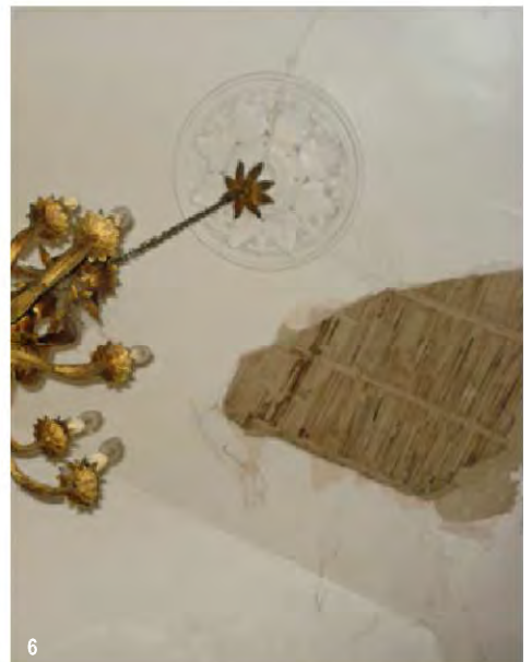
1.Fachada principal 2.Pormenor do interior do telhado de tesouro com estrutura de madeira 3.Pormenor do tecto do telhado de tesouro com canas, na sala 4.Pormenor de porta de entrada da fachada posterior 5.Vista da fachada posterior 6,Pormenor do tecto do telhado de tesouro. (fotografias do autor entre Maio e Agosto 2009)
