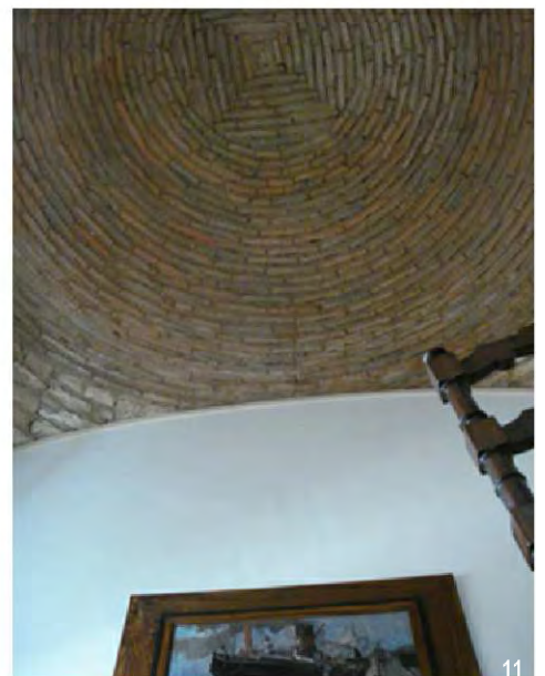
7.Pormenor da açoteia na zona da abóbada de berço abatido 8.e 9.Abóbada de berço abatido da antecâmara 10.Açoteia na zona da abóbada de vela da divisão principal 11.Pormenor central da abóbada de vela da divisão principal. (fotografias do autor entre Maio e Agosto 2009 )
