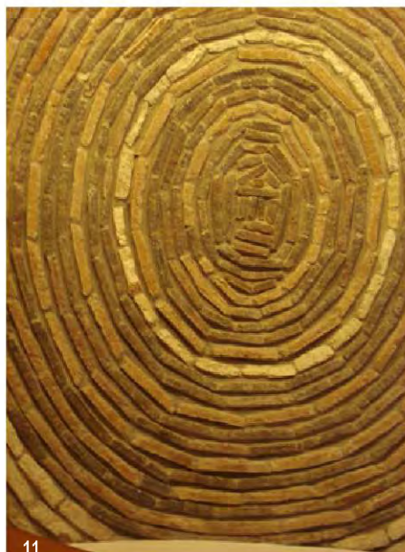
7.Açoteia na zona da abóbada de vela da divisão principal 8.Açoteia na zona da abóbada de berço abatido das divisões interiores 9.Pormenor da abóbada de berço abatido da instalação sanitária 10. e 11.Pormenores da abóbada de vela da divisão principal 12.Abóbada de berço abatido da sala de jantar.(fotografias do autor entre Maio e Agosto 2009)
