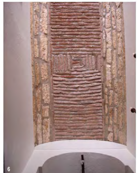
1.Pormenor da abóbada de vela com clarabóia da sala anexa a sala principal 2.Pormenor da abóbada de berço abatido da antiga cozinha 3.Abóbada de berço abatido da antiga cozinha 4,Fachada principal 5.Abóbada de berço abatido no corredor 6,Pormenor da abóbada de berço abatido no corredor, (fotografias do autor entre Maio e Agosto 2009)
