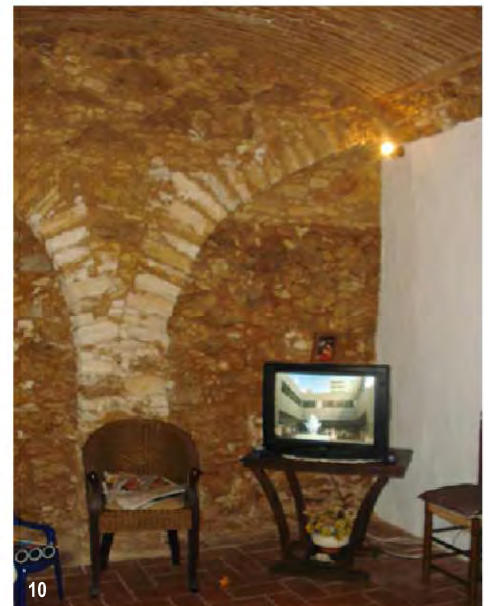
6.Pormenor do pavimento 7.Abóbada de berço abatido existente na cozinha 8.Abóbada de berço no vestíbulo 9.e 10.Arcos estruturais embutidos na parede da sala. (fotografias do autor entre Maio e Agosto 2009)
