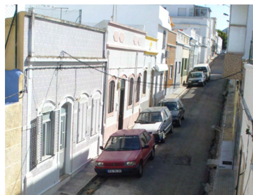
Fig.III.25 – Fachadas na Rua das Vinhas.
