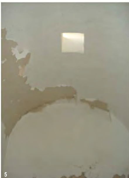
1.Fachada principal 2.Pormenor da abóbada de berço abatido no compartimento da instalação sanitária 3.Pormenor da estrutura de abóbadas e arcos 4.Abóbada de vela em compartimento interior 5.Pormenor de abóbada de berço abatido em compartimento interior 6.Vista do compartimento posterior.(fotografias do autor entre Maio e Agosto 2009)
