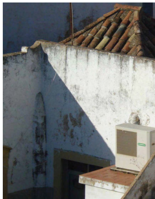
Fig.III.49 – Canalização das águas da açoteia, em tipologia unilateral com cobertura de Telhado de Tesouro , na Rua da Liberdade.
