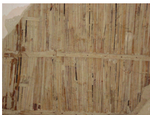
Fig.III.43 – Pormenor do tecto em encaniçado da sala.
