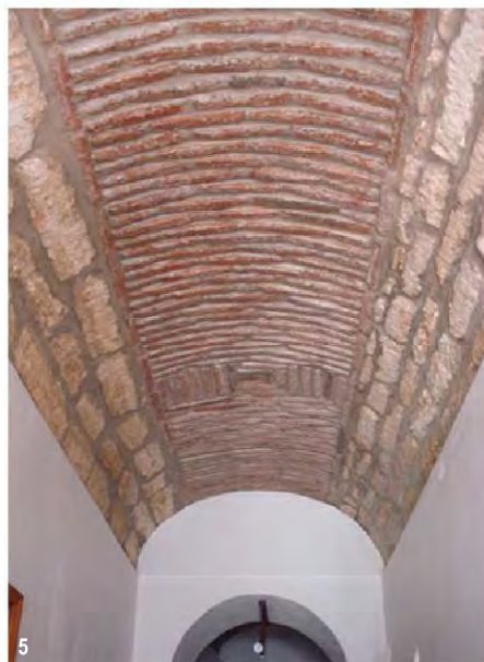
1.Pormenor da abóbada de vela com clarabóia da sala anexa a sala principal 2.Pormenor da abóbada de berço abatido da antiga cozinha 3.Abóbada de berço abatido da antiga cozinha 4,Fachada principal 5.Abóbada de berço abatido no corredor 6,Pormenor da abóbada de berço abatido no corredor, (fotografias do autor entre Maio e Agosto 2009)
