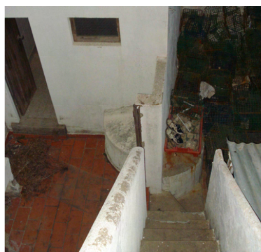
Fig.III. 57 – Escada de acesso à açoteia com poço no alinhamento, em tipologia unilateral com cobertura em açoteia, no conjunto da Rua Contra-Almirante Marcelino Carlos.
