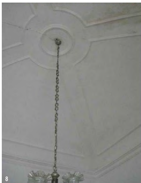
6.Abóbada de berço abatido do corredor 7.Abóbada de berço abatido da cozinha 8.e 9.Pormenor central da abóbada em barrete de clérigo da divisão principal. (fotografias do autor entre Maio e Agosto 2009)
