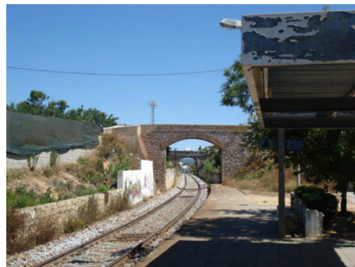
Fig.I.10 – Apeadeiro “Fuseta -A” com a Ponte Pequena e seguidamente a Ponte Grande ao fundo.
