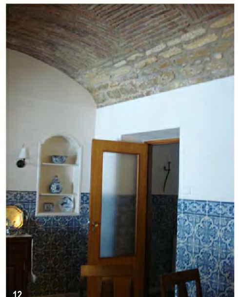
7.Açoteia na zona da abóbada de vela da divisão principal 8.Açoteia na zona da abóbada de berço abatido das divisões interiores 9.Pormenor da abóbada de berço abatido da instalação sanitária 10. e 11.Pormenores da abóbada de vela da divisão principal 12.Abóbada de berço abatido da sala de jantar.(fotografias do autor entre Maio e Agosto 2009)
