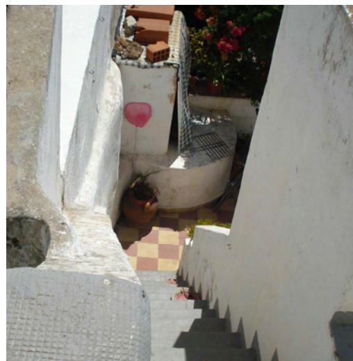
Fig.III. 55 - Escada de acesso à açoteia com poço no alinhamento, em tipologia unilateral com cobertura em açoteia no conjunto da Rua do Carmo.
