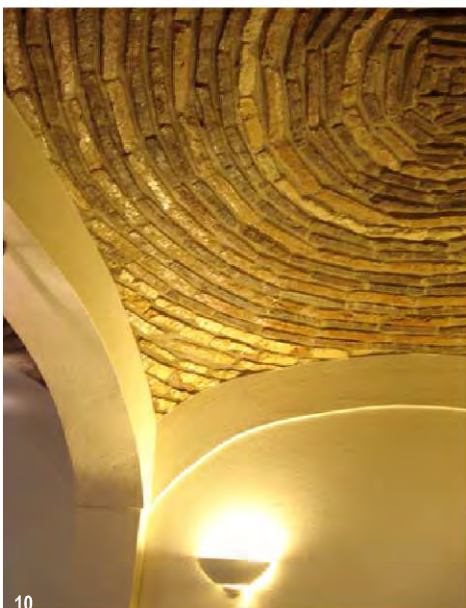
7.Açoteia na zona da abóbada de vela da divisão principal 8.Açoteia na zona da abóbada de berço abatido das divisões interiores 9.Pormenor da abóbada de berço abatido da instalação sanitária 10. e 11.Pormenores da abóbada de vela da divisão principal 12.Abóbada de berço abatido da sala de jantar.(fotografias do autor entre Maio e Agosto 2009)
