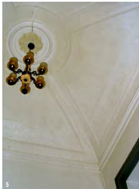
1.Pormenor das janelas da fachada 2. Abóbada de berço abatido de compartimento interior (alcova) 3.Corredor com abóbada em barrete de clérigo 4.Fachada principal 5.Abóbada em barrete de clérigo em compartimento principal (quarto) 6.Corredor com abóbada em barrete de clérigo. (fotografias do autor entre Maio e Agosto 2009)
