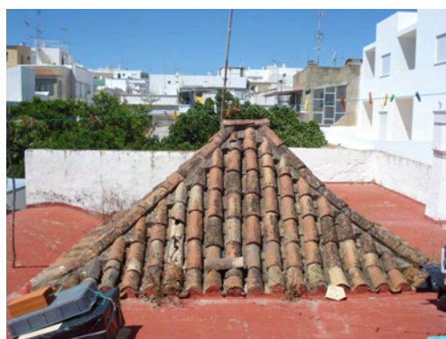
Fig.III.41 – Pormenor do Telhado de Tesouro na Rua da Liberdade nº 45.
