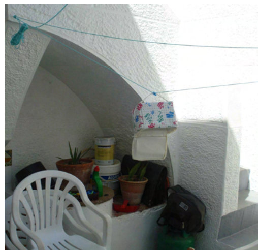
Fig.III.58– Escada de acesso à açoteia com poço no vão, em tipologia bilateral com cobertura em açoteia, na Rua Dr. Teófilo Braga.
