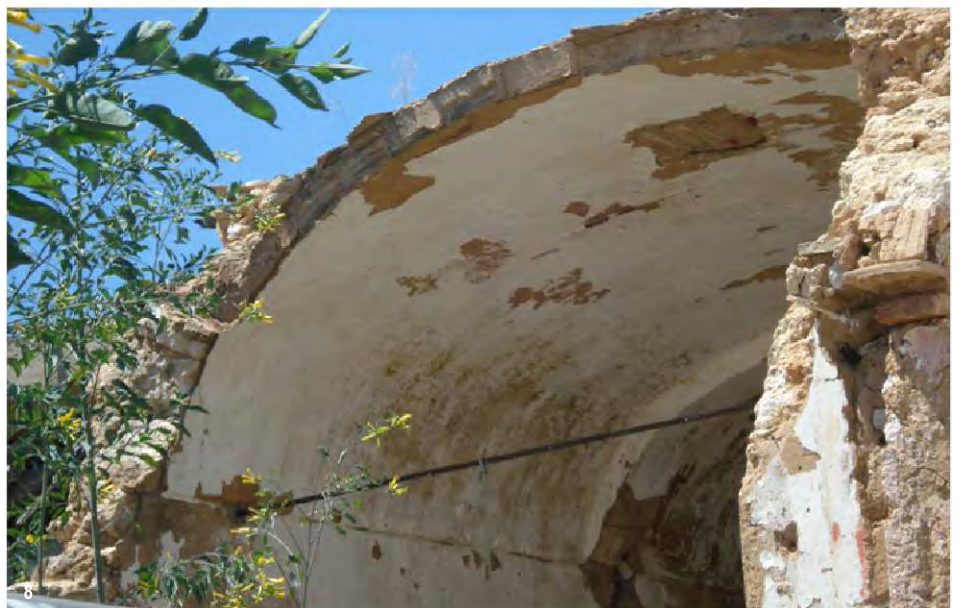
5.Vista geral do conjunto 6.Pormenor do arranque da abóbada de berço abatido 7.Pormenor da cantaria e estrutura interna do telhado de três águas 8.Abóbada de berço abatido de uma das naves. (fotografias do autor entre Maio e Agosto 2009)
