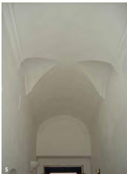
1.Açoteia com cobertura da abóbada de vela da antecâmara 2.Pormenor lateral da abóbada de vela 3.Abóbada de vela da antecâmara (actual cozinha) 4.Fachada principal 5.Abóbada de berço abatido com pormenor central, no corredor 6.Escada de acesso à açoteia (fotografias do autor entre Maio e Agosto 2009)
