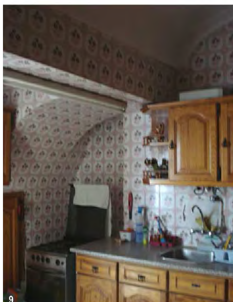
6.Abóbada de berço abatido do corredor 7.e 8.Pormenores da açoteia na zona da abóbada de vela 9.Cozinha com abóbada de berço abatido e vão da escada para a açoteia 10,Pormenor da açoteia da abóbada de vela 11.Escada de acesso à açoteia. (fotografias do autor entre Maio e Agosto 2009)
