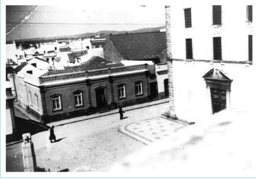
Fig. 2 Foto antiga de parte da fachada da Igreja Matriz de Olhão.
