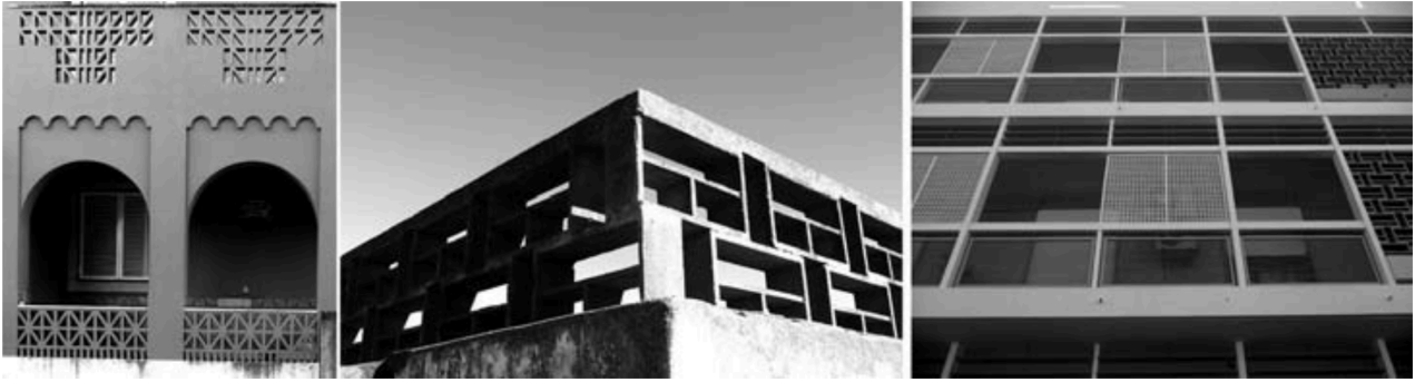
Raul Lino, 1932: Huis aan de Avenida Dr. Mateus Teixeira de Azevedo, Tavira; Rooster van de omheining van de Ginasio clube Tavira. MGdC, Gebouw in Rua Camilo Castelo Branco, VRSA.
